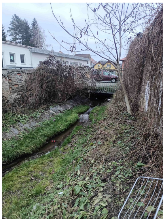
Pohled na vtok do zatrubnění Vrutice (pod začátkem odstraňované opěrné zdi), u kterého bude na pravé straně vtoku umístěn staveništní vodočet.
