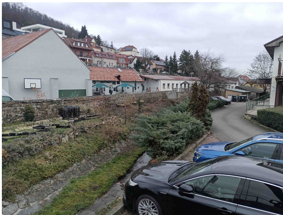
Pohled na (po směru toku Vrutice) na opěrnou zeď, která bude v rámci demolice odstraněna.
