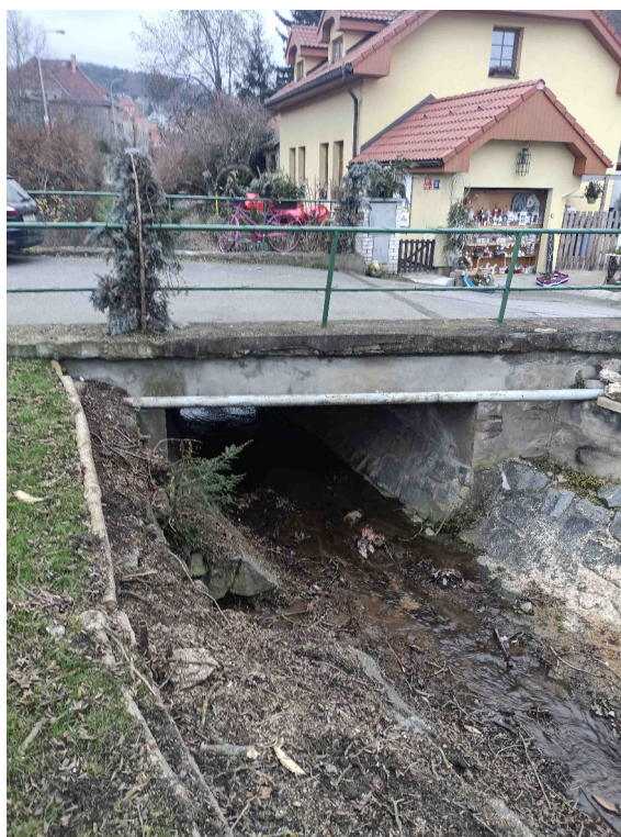
Příjezd po přemostění Vrutice ze Starochuchelské ulice k horní části staveniště (opěrné zdi).
