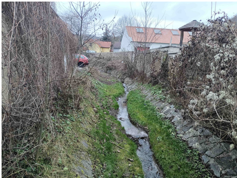
Pohled (proti toku Vrutice) na opěrnou zeď, která bude v rámci demolice odstraněna.
