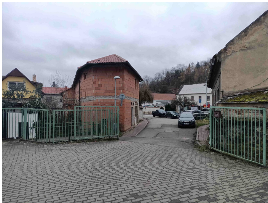
Příjezd ze Starochuchelské ulice k RD č.p. 87/8 a proti toku Vrutice také k opěrné zdi umístěné na levém břehu Vrutice.
